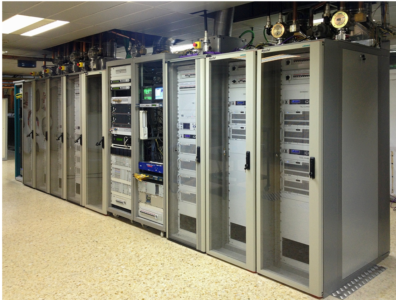
Transmisores de alta eficiencia energética (Serie HET) Sistema 3+1 de 1 kWrms DVB-T/T2 en el centro de "Domaió" (ESPAÑA. 2013)
